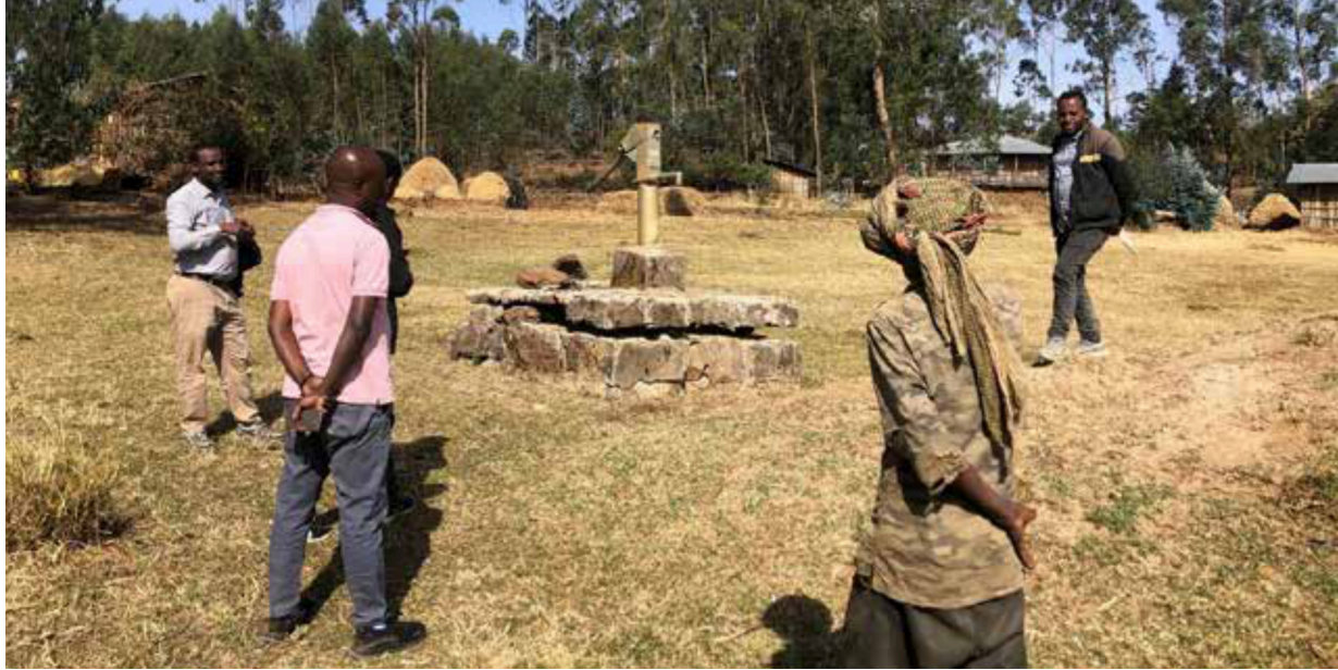
Tansania: In einem ersten Schritt werden defekte Wasserpumpen identifiziert und geprüft, ob für eine Reparatur in Frage kommen.
